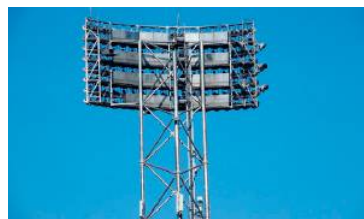
An den Sportstätten werden Anlagen installiert. Symbolfoto: pixabay
